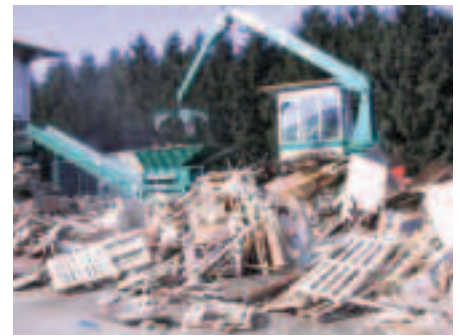
Auch ein Schwerpunkt des Unternehmens: die Altholzaufbereitung. Die neue Anlage ist seit Februar 2004 in Betrieb und ist mit 15 Tonnen pro Stunde die leistungsfähigste Anlage in Westösterreich.
