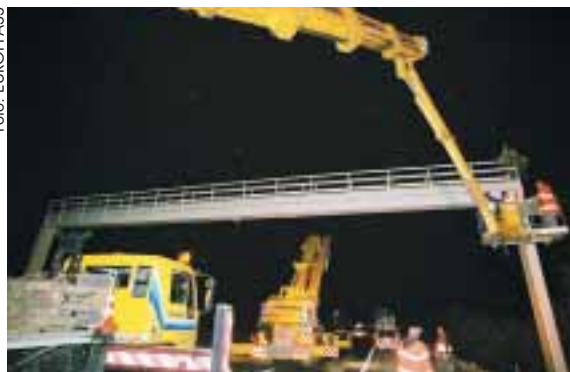
Totalansicht eines Mautportals während seiner Errichtung
