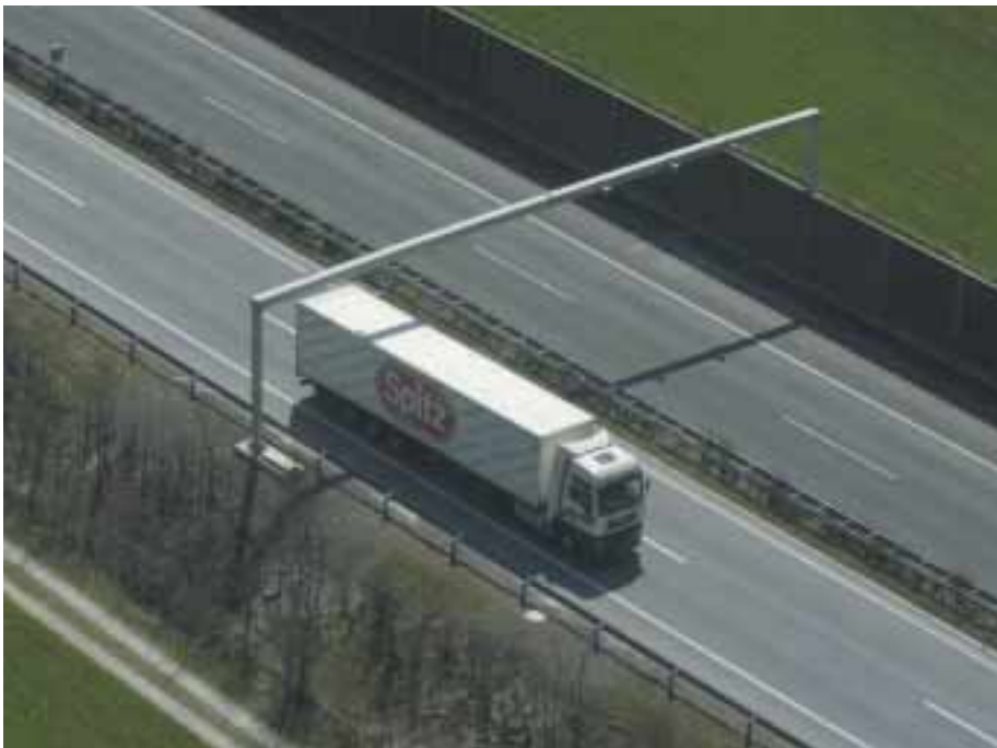
Vollelektronische Abrechnung der Wegstrecken mittels Mikrowellen – im Bild ein exemplarisches Mautportal.
