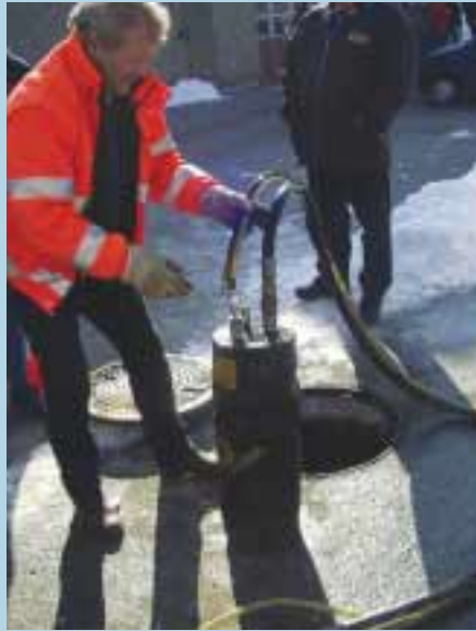
Herbert Egger, der Praxisreferent und „Abdruckguru“ aus der Steiermark, beim Einbau des Dichtkissens
