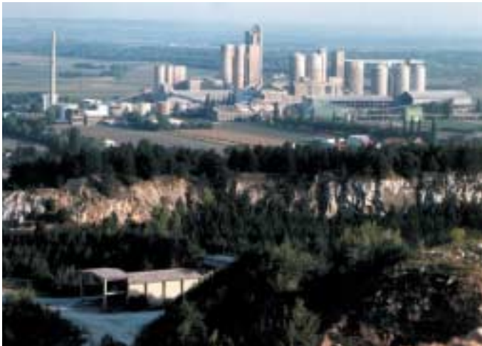
Ein „klassischer“ Einsatzort für die industrielle Mitverbrennung: die heimische Zementindustrie (im Bild das Zementwerk Mannersdorf der Lafarge-Perlmooser AG).
